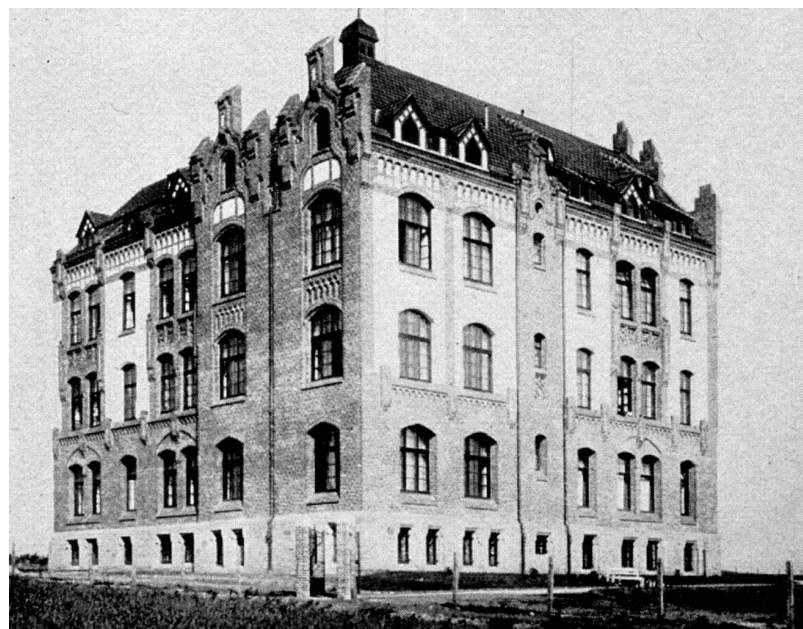
Bürgerengagement in Stein gemeißelt: Der erste Bauabschnitt (1904)
